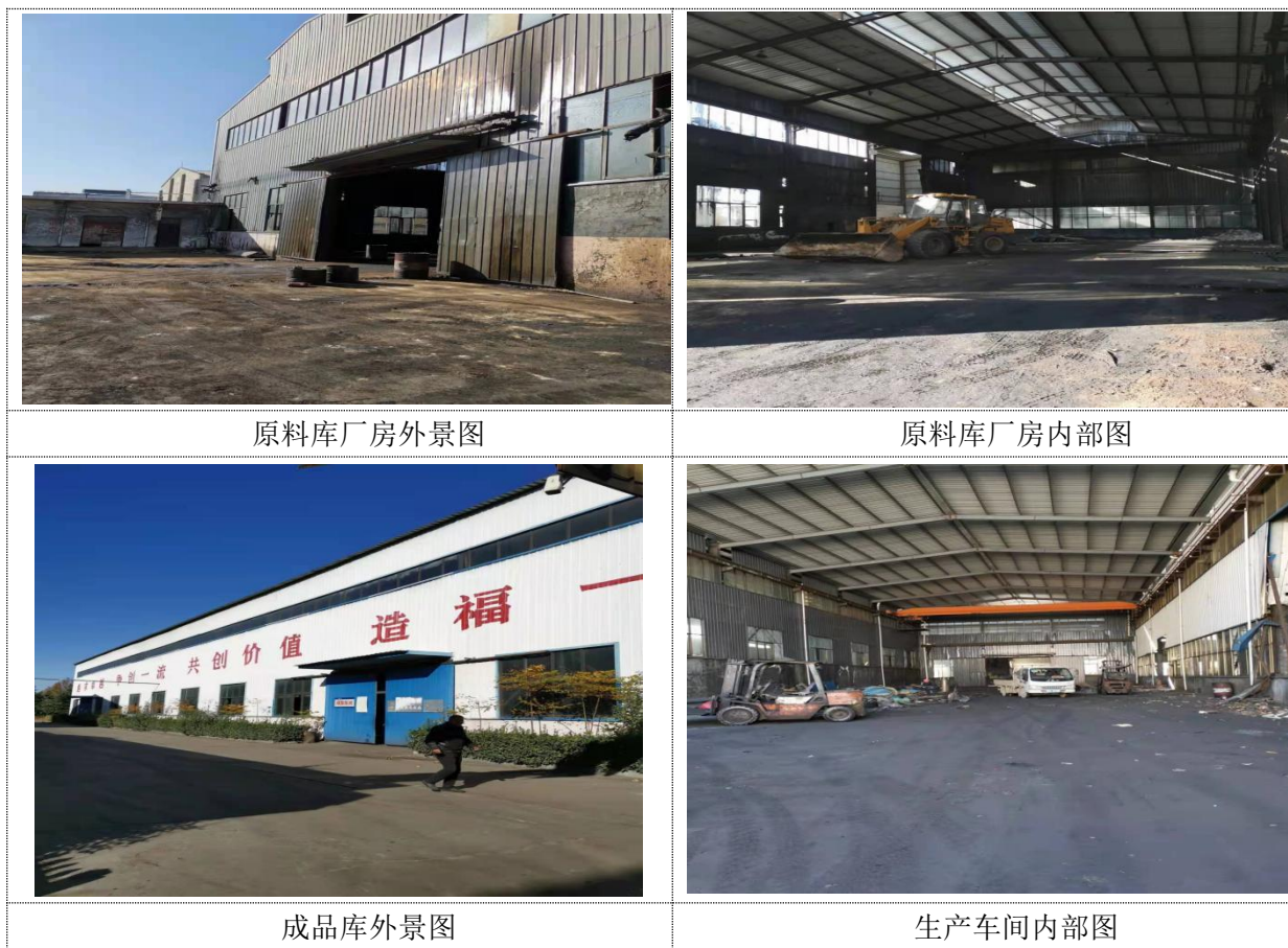
图 3.3-1 租赁厂房外景和内部实景图
