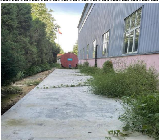
现有工程消防储罐和事故池
