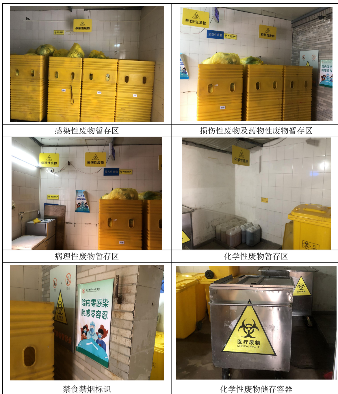
图 7.4-1 医疗废物暂存间现状
