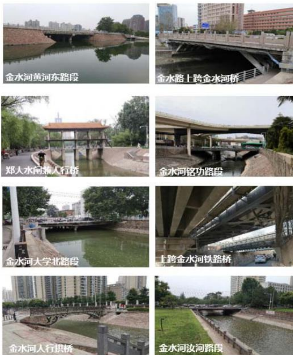
图 2-2 部分桥梁现状图
