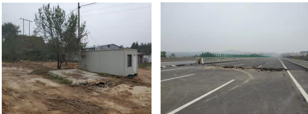
图3.3-1 本项目起终点现状（左图：起点，右图：在建 G310）
