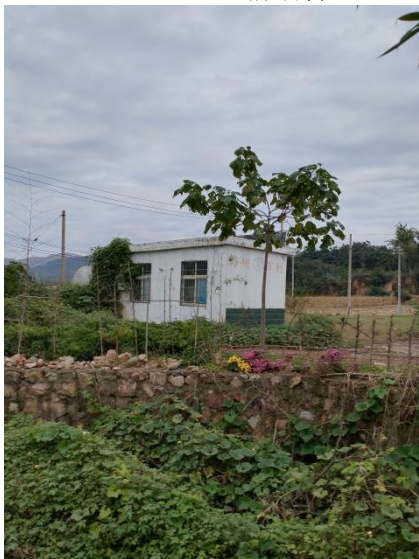
后湾村供水站（深水井）
