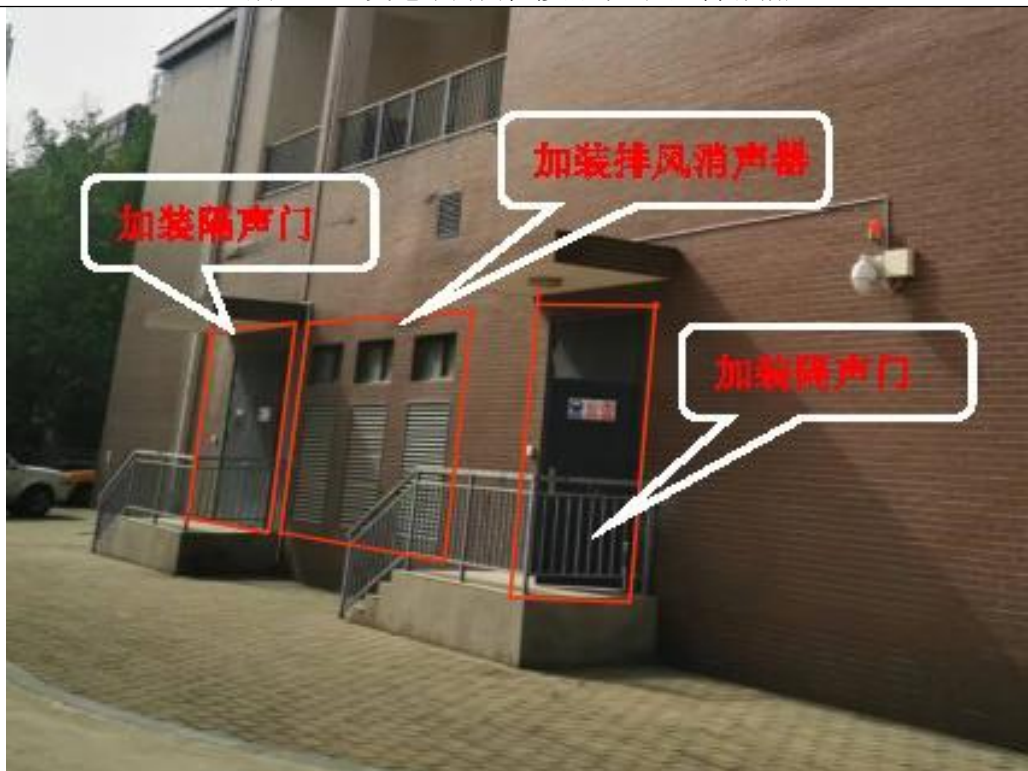
红旗 220kV 变电站北面检修门与通风口降噪措施
