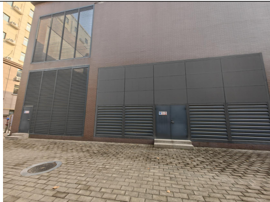
本期扩建3号主变预留位置
