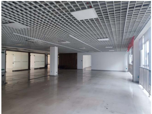
项目厂房现状
