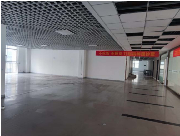
项目厂房现状
