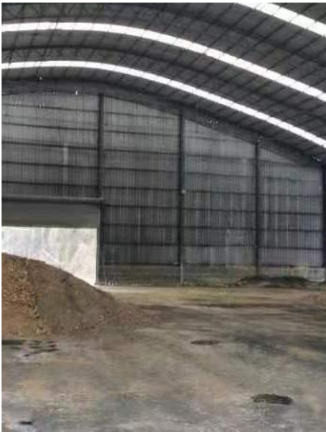
现有厂区（宋楼老厂）现状照片
