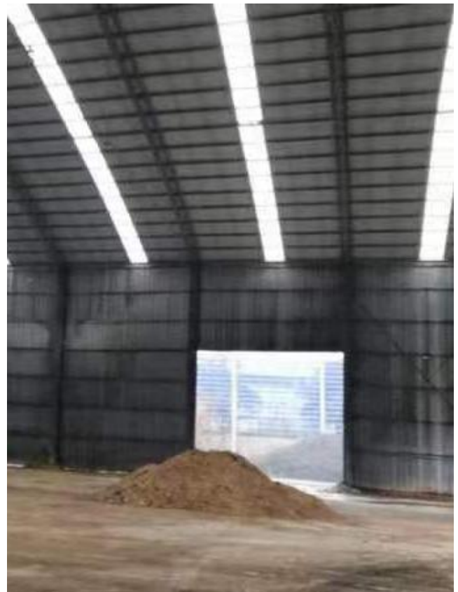
现有厂区（宋楼老厂）现状照片
