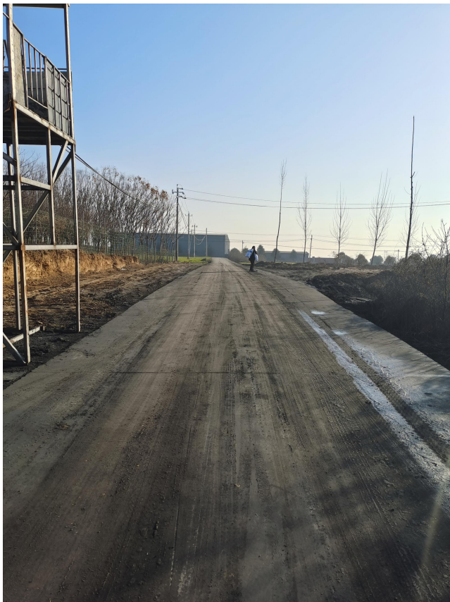
项目东侧入厂道路
